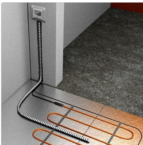
9. Измерьте сопротивление секции и датчика, сверьте с данными в инструкциях (паспортах) и зафиксируйте его.
